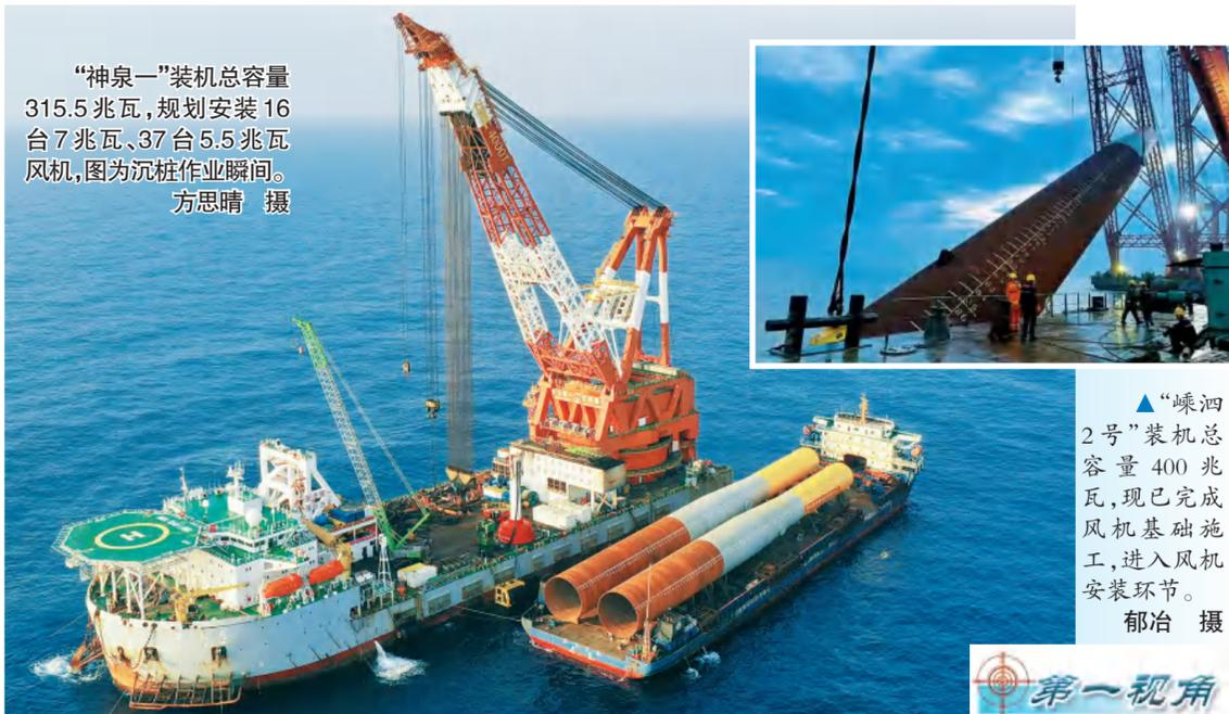
“神泉一”装机总容量315.5兆瓦,规划安装16台7兆瓦、37台5.5兆瓦风机,图为沉桩作业瞬间。
